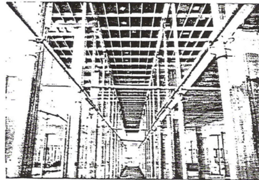
FIGURA 3.49 ARRIOSTRAMIENTO DE LOS PUNTALES DEL ENCOFRADO.
