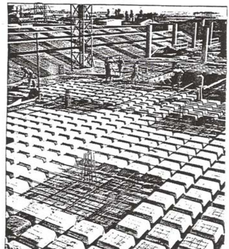
FIGURA 3.54 ENCOFRADO PARA FORJADO CON CASETONES RECUPERABLES
